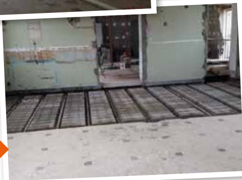
La structure du plancher existant étant fragilisée par la rouille, le plancher sur la cave a été remplacé
