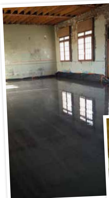
Vue de la salle principale après coulage de la dalle
