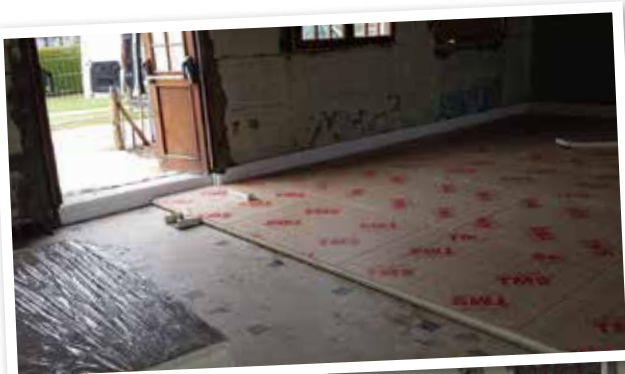
Une isolation thermique a été mise en place sur toute la surface du plancher
