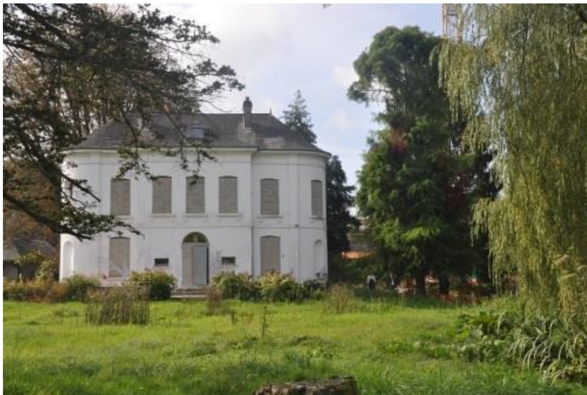
Exemple de bâti ancien de qualité sans vocation industrielle mais situé en zone UY du POS
